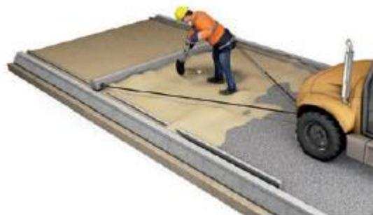
En cas de pose mécanique des pavés, le lit de pose est précompacté à la plaque vibrante pour éviter l'orniérage éventuel provoqué par la machine évoluant sur les pavés non compactés.
