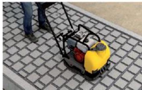
On procède ensuite à un damage en partant du centre de la surface au droit des rives, en prenant soin de déborder sur le passage précédent.
